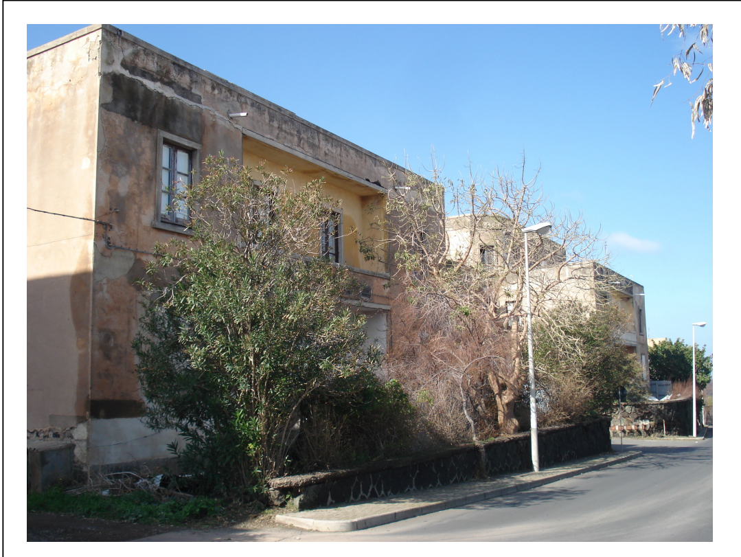
Foto 1 - Via S. Nicola - Palazzine da demolire
